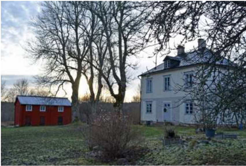
Figur 3. Mangårdsbyggnaden och södra flygel ifrån norr. Foto C. Andreasson
