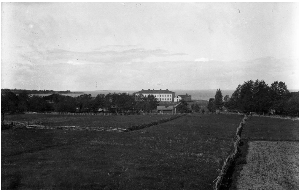
Figur 101: Eckerö Post- och tullhus uppfördes i öppen terräng i utkanten av Storby på Eckerö. Fotot är taget i början a 1900-talet och visar anläggningen bortom Storbys då fortfarande mycket öppna åkrar och ängar.
