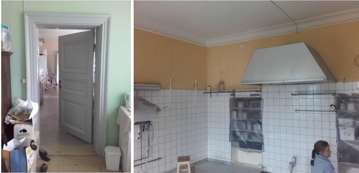
Figur 33–34 Dörr mellan rum 12 och 15 samt delar av köksinredning i rum 16
