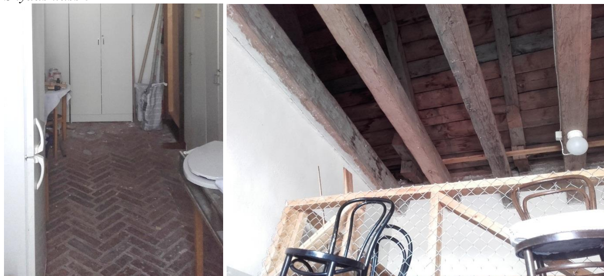
Figur 87–88: tegelgolv i rum 44 och öppen takkonstruktion i rum 45
