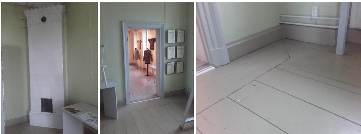
Figur 39–41: Kakelugn, dörrfoder och golv (rum 18)
