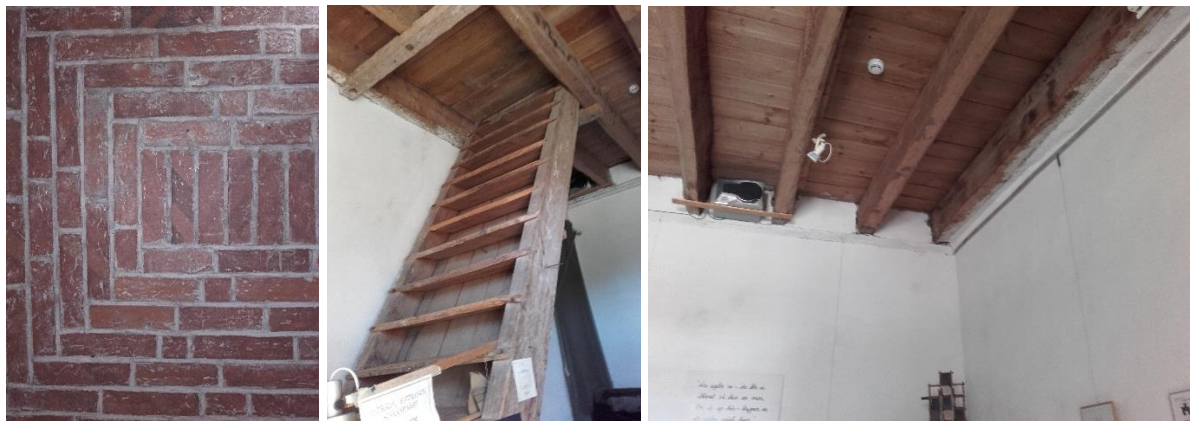
Figur 68–70 Tegelgolv, vindstrappa och takbjälkar (rum 35)
