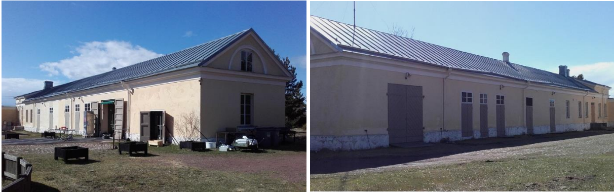
Figur 9–10: Norra- och södra flygeln från gårdsplanen
