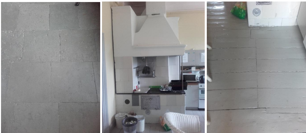
Figur 47–49 Ursprungligt kalkstengolv i trapphus (rum 21). Köksspis och skarv i trägolv. (rum 22)
