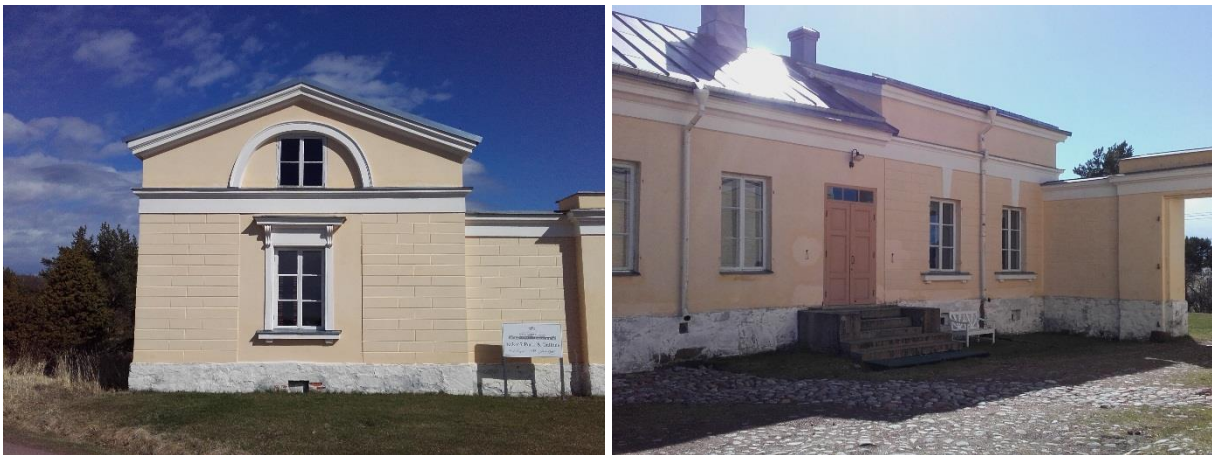
Figur 11–12: Norra flygelns gavel från väst och södra flygeln från nordost
