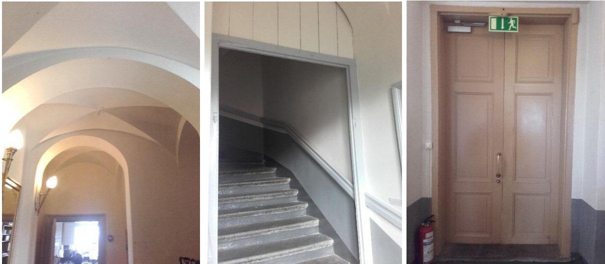
Figur 30–32: kryssvalv och dörrar i södra trapphuset (rum 11) Notera anordningen för automatisk stängning på bild 32.
