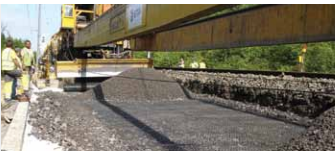
Fördelar med Tensar grundstabilisering på järnvägar
