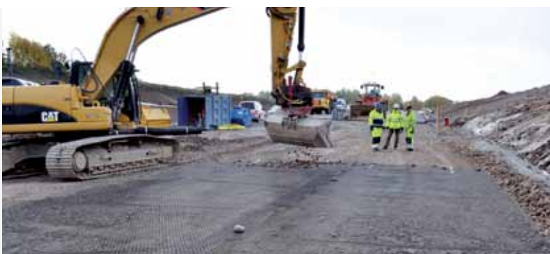
Förstärkning av överbyggnad, Ringvägen Linköping
