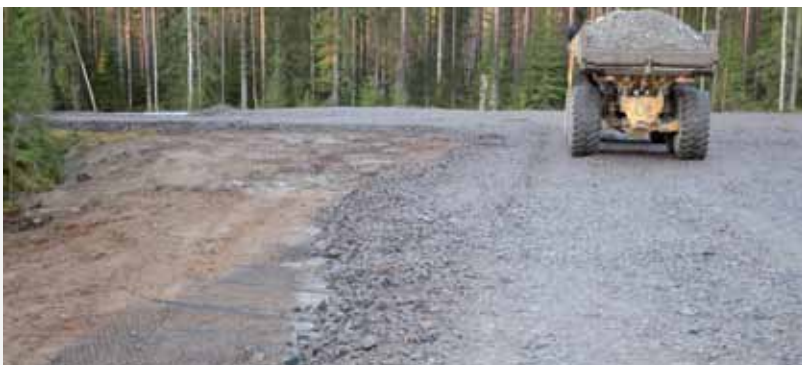
Förstärkning av vägar för vindkraftsbyggande, Jädraås, Gävle
