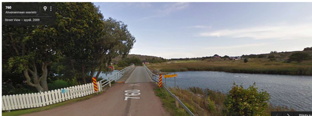
Bild 7. Karlby bron sett från väster.
