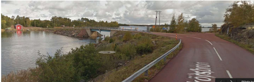
Bild 12. Nuvarande Djurholm sunds bro sett från söder.
