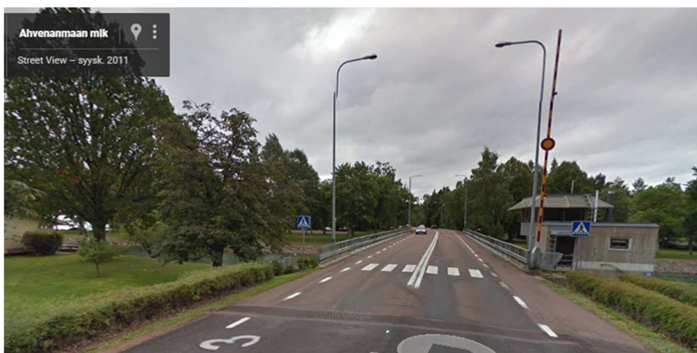
Bild 10. Lemströms kanalbro sett från norr.
