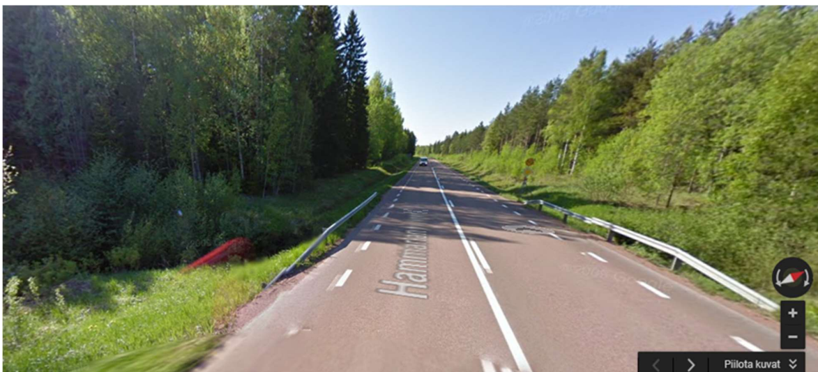
Bild 1. Korsbron sett från sydost.
