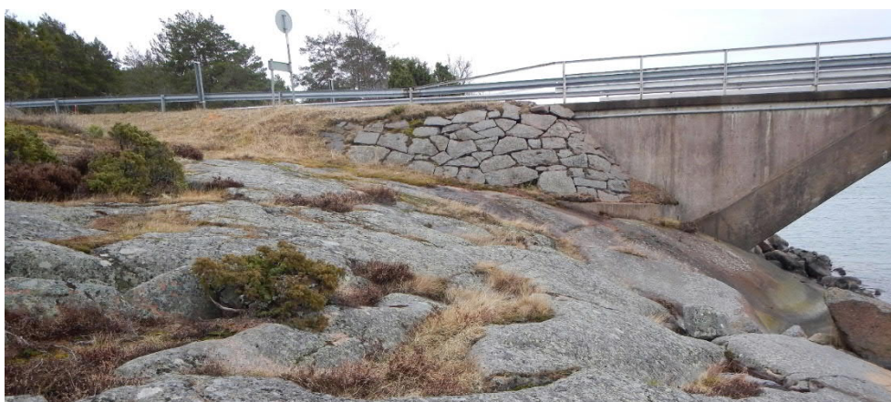
Figur 7. Prästösidas brofäste befintlig bro, norra sidan, vy mot söder.
