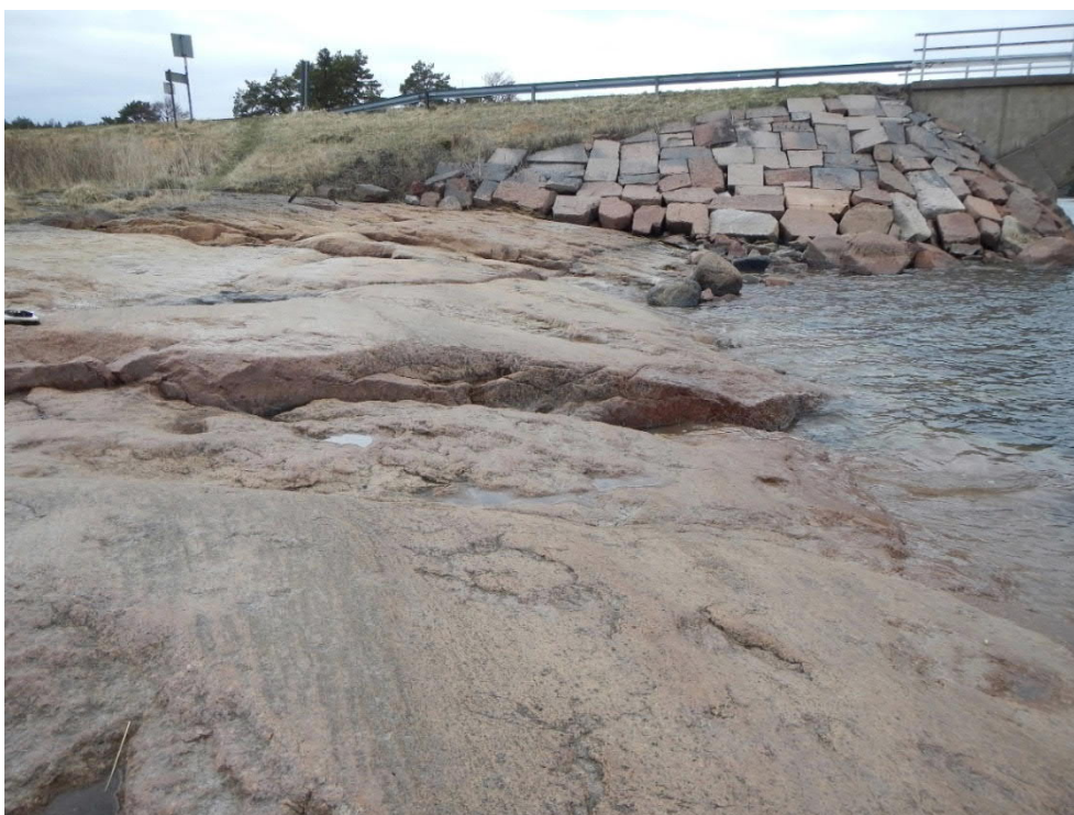
Figur 5. Bomarsundsidas brofäste befintlig bro, södra sidan, vy mot norr. De flacka lågt liggande hållarna som syns i förgrunden utgör en udde på vilken västra brofästet ligger.
