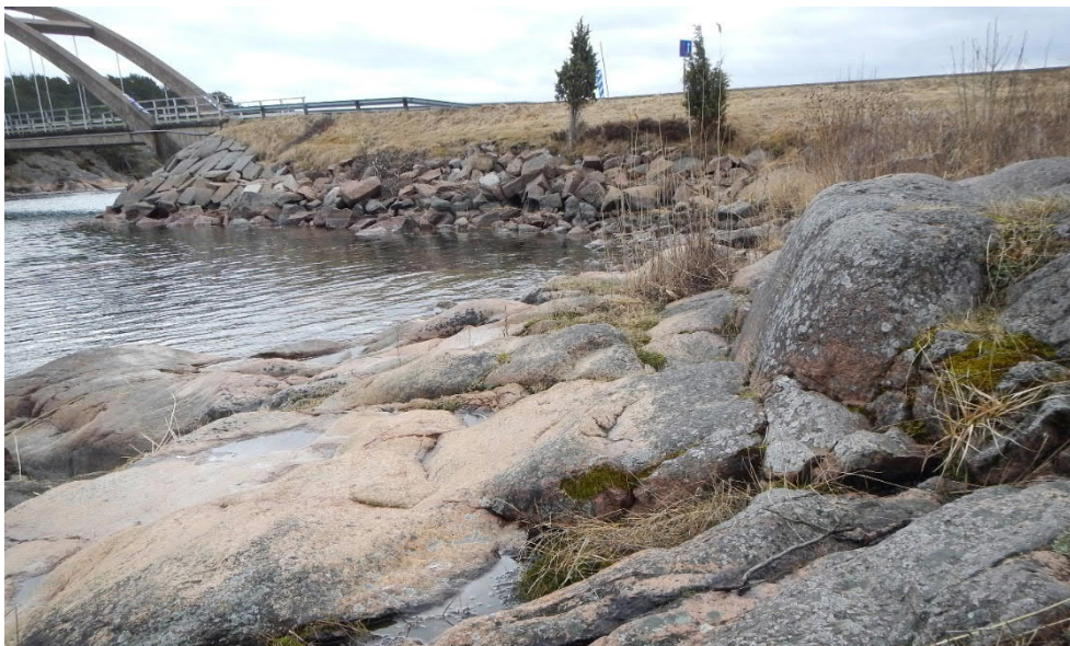
Figur 4. Bomarsundsidas brofäste befintlig bro, norra sidan, vy mot söder. Här syns fyllnadsmassor på fast berg i anslutning till västra brofästets norra sida.
