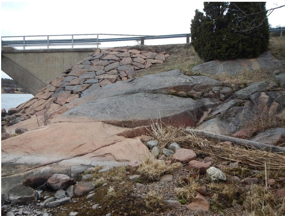
Figur 11. Prästösidans brofäste befintlig bro, södra sidan, vy mot norr.
