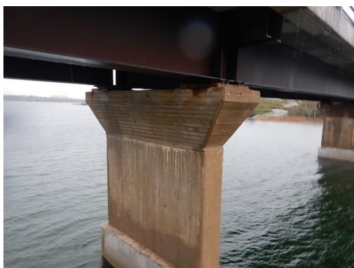
Figur 21.2 Typskada på skivpelare
