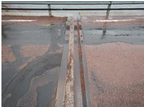
Figur 32.1 Övergångskonstruktion vid landfäste
