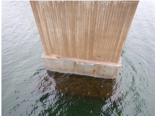
Figur 21.3 Yta för ytbehandling skivpelare
