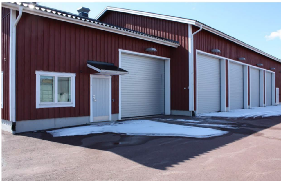
Möckelö oljeskyddslager färdigställdes under våren 2005
