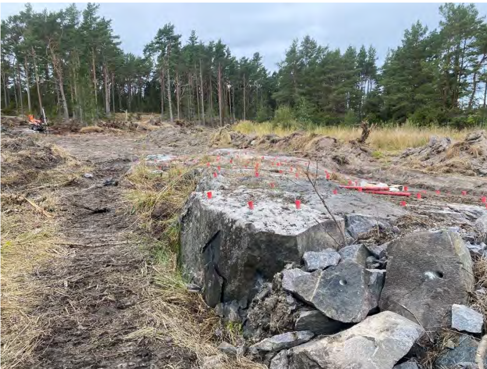
Figur 18. För att få bra styckefall har täta borrhål/laddningar använts. Sprängarbetsplats 2.
