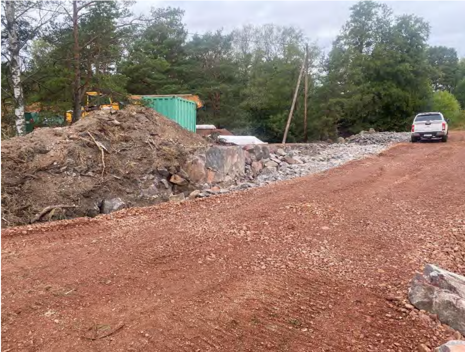
Figur 13. Sprängningsarbeten pågick under fältarbetets gång vid vägens norra sida (km ca 0/275) vilket förenklade observationer i de färskas schakterna. Sprängarbetsplats 1. IMG_0155.JPG.
