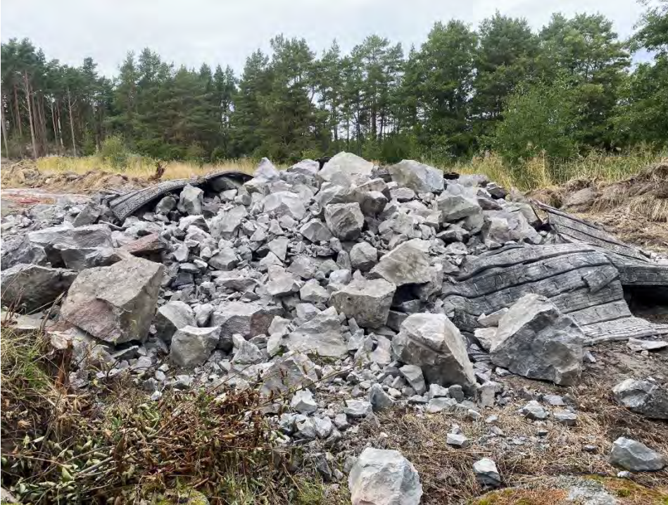
Figur 17. Trettio minuter gammal salva. Sprängarbetsplats 2 (ca km 0/300), stax sydväst om Sprängarbetsplats 1. De största blocken, även vid tät borring och laddning är ca en meter. IMG_0233.jpg
