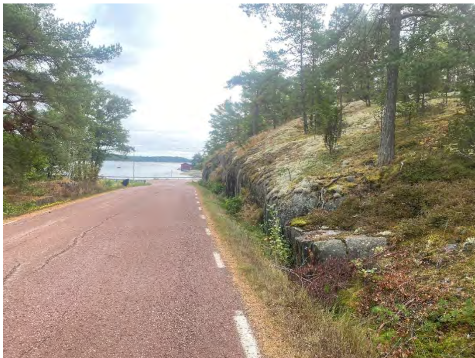
Figur 15. Öster om sprängarbetsplats 1. Bild (IMG_0178.JPG) tagen vid km 0/180, österut mot km 0/000. Med stigande kilometertal flackar slänten sedan ut. Slänten är bevuxen med mossa och högre upp dominerar ett tunt jordtäckte på berg.
