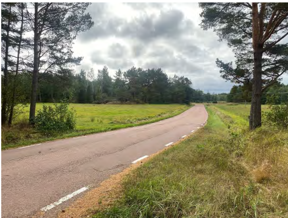
Figur 35. Bild tagen mot sydväst. Ny väg kommer här (km 1/650 – 2/850) till vänster i bild på befintlig vägs vänstra sida, nära området som sticker upp som hällar i odlingslandskapet.
