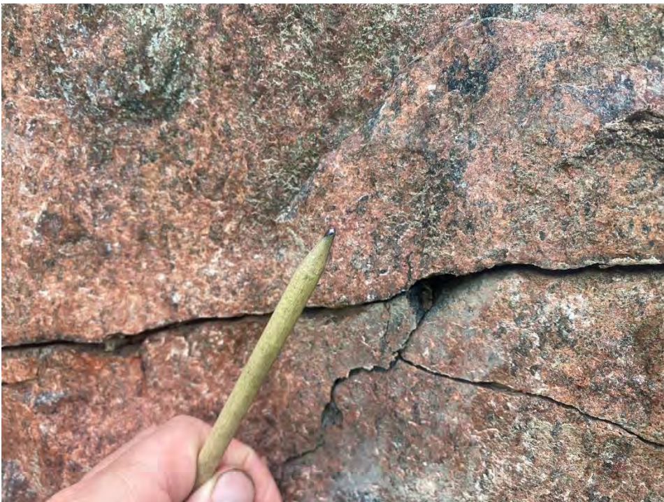
Figur 14. Närbild på förekommande sprickor i området. Sprickor har påverkats och öppnats upp av förekommande sprängningar på platsen. Sprängarbetsplats 1. IMG_0152.JPG
