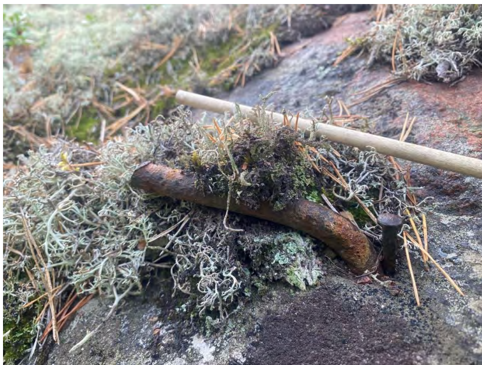
Figur 16. Enda påträffade bergförstärkningen på sträckan, vid 0/180. Funktionen är i dagsläget oklar. IMG_0181.jpg
