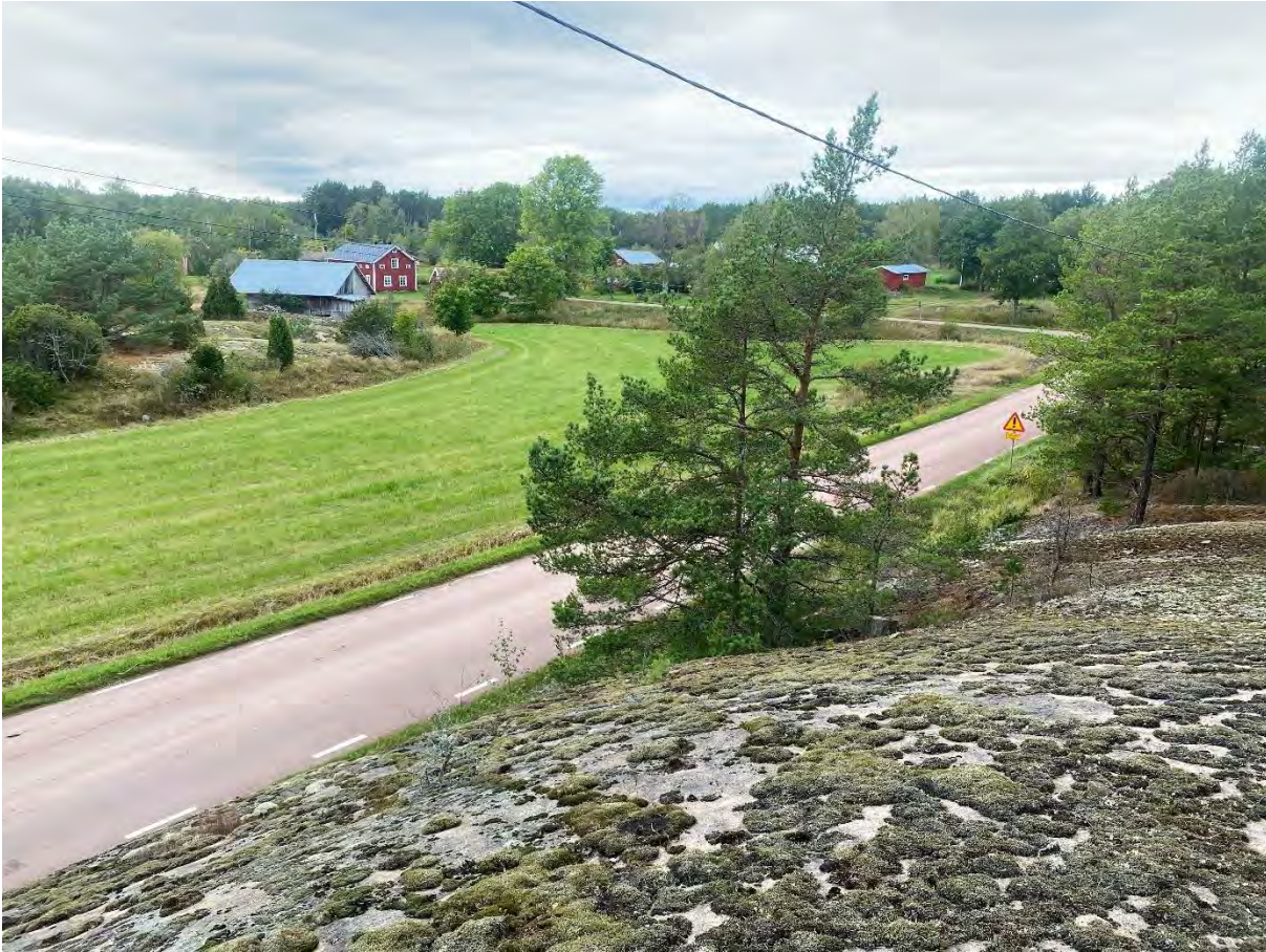
Figur 46. Högt (ca 12 m), långsträckt släntavsnitt på vägens nordöstra sida.IMG_0415.jpg vid omkring km 3/825.
