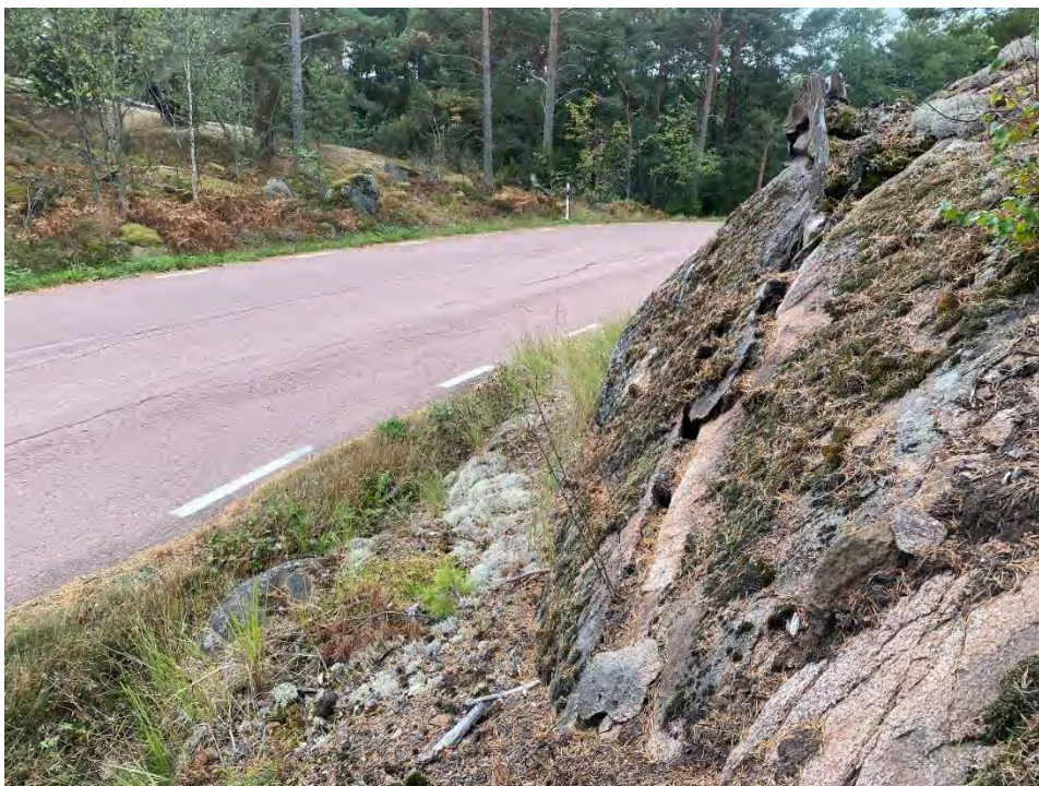
Figur 30. Ytterligare ett block som glidit ut. Nere vid släntfoten finns block som tidigare fallit ut.
