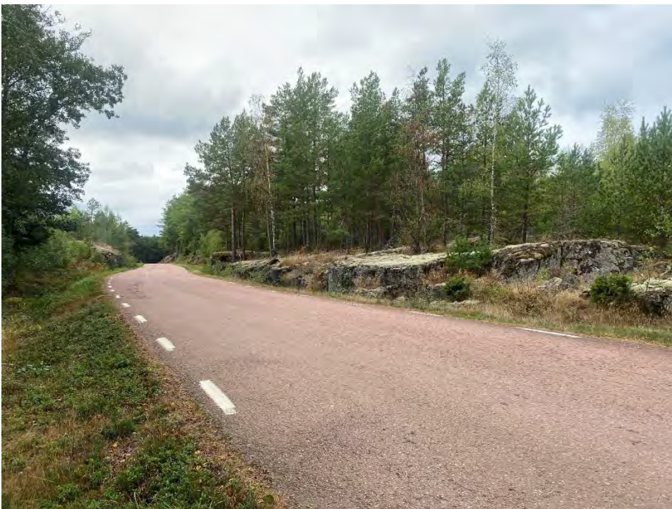
Figur 27. Förekommande bergskärning på befintlig väg nordvästra sida, ca km 1/050. IMG_0289.jpg
