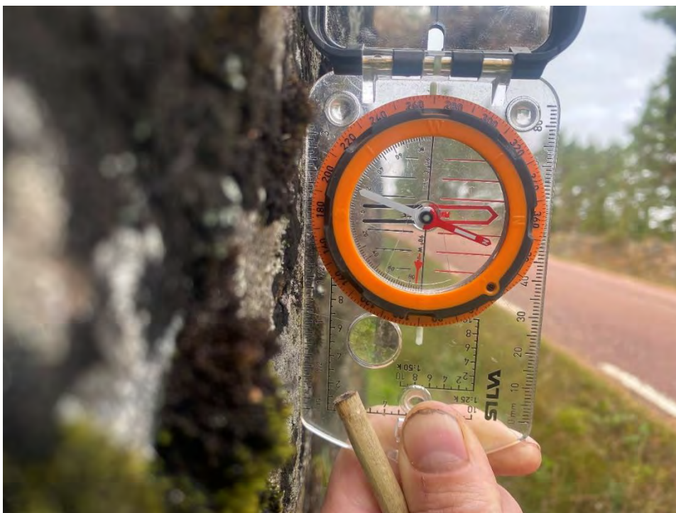
Figur 10. Skärning längst mot norr står i 80-82° utan andra åtgärder än att enstaka block skrotats. Bedöms stabil under befintlig situation. Km ca 0/030. IMG_0185.jpg.
