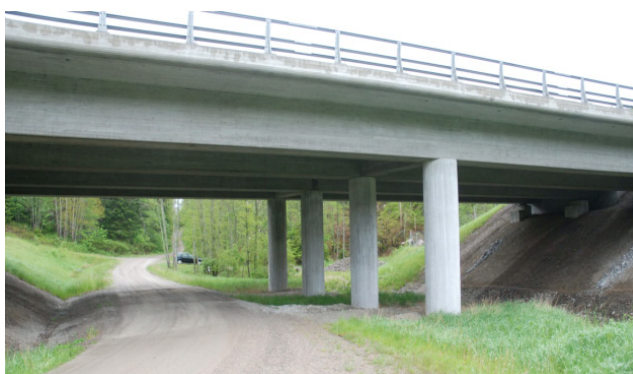
Figur 30. Exempel på en faunaanpassad vägbro. Källa: Trafikverket 2012.
