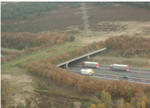
Figur 29. Exempel på en ekodukt där djuren passerar över vägbanan. Källa: Trafikverket, 2012.
