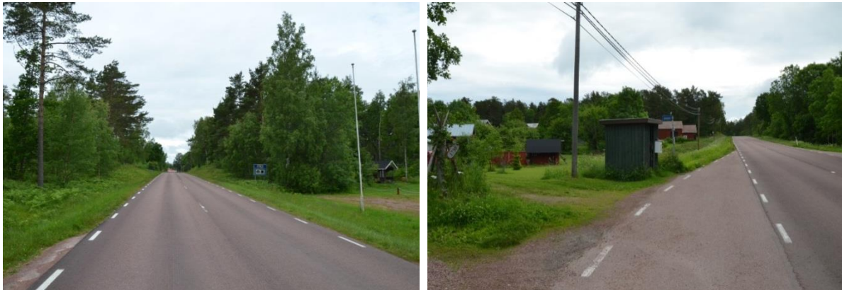
Figur 5.23 Dagens väg genom Prästö. Vägren saknas. Fotot till vänster är taget vid campingen, det högra är taget vid busshållplatsen på mitten av Prästö.
