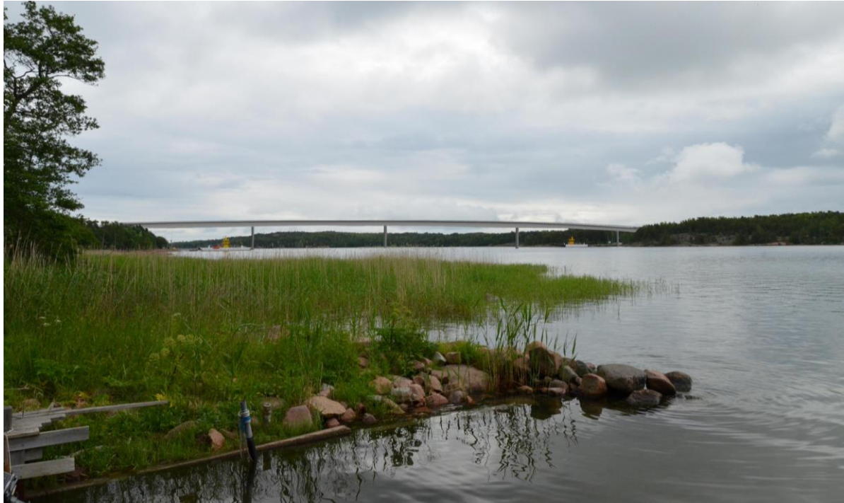
Figur 5.8 Fotomontage – broalternativ A över Prästösund (18 m segelfri höjd), visualisering av påverkan på landskapsbild. Fotot är taget från stranden på Prästö, cirka 250 meter söder om dagens linfärja.
