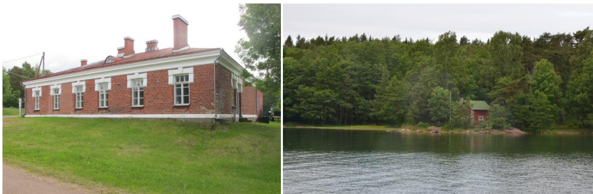
Figur 5.3 Telegrafbyggnaden på Prästö byggd ca 1912-13 (till vänster). Till höger syns stranden söder om färjfästet på Prästö. Nära stranden finns äldre markstrukturer som återfinns på kartan från 1775.
