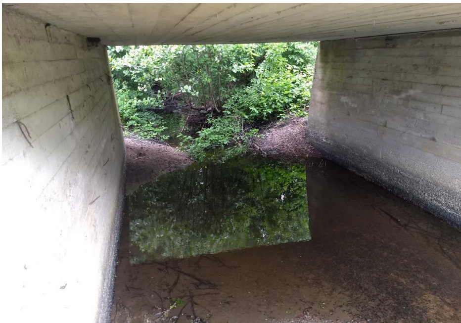
Figur 1 Insidan av bron, visar vattenmärken på konstruktionen.
