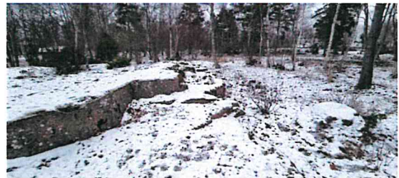
Översikt objekt 2. Från syd. Foto: B211209_03.jpg
