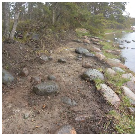
Figur 12. Översikt landfästet, anläggning 9. Från V. Foto B200513_05.jpg
