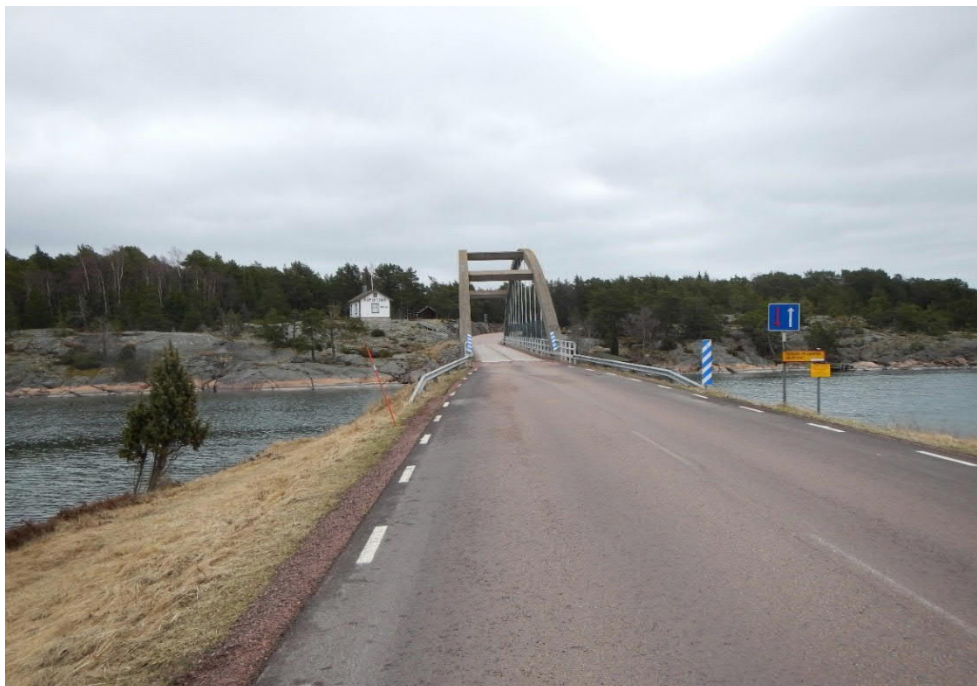
Figur 6. Befintlig bro. Vy mot Prästö, från Bomarsundsidas. Notera uppbyggnaden, upp ovan den låga och flacka fasta berggrunden på Bomarsundsidas i jämförelse med de mjukt rundade och men från en betydligt högre höjd, mot sundet sluttande hållarna.
