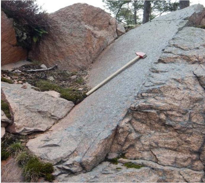
Figur 8. Exempel på plan spricka med intermediär branhet på Prästösidan, som har en diagonal utsträckning relativt sundet, och stupar 40° mot NV.
