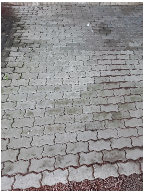
Avser släntbeklädnad under bro södra sidan
