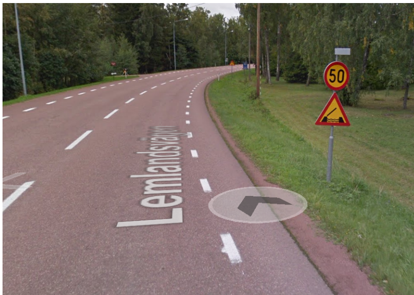
Figur 1 Försignal placeras i samma läge som skylt
