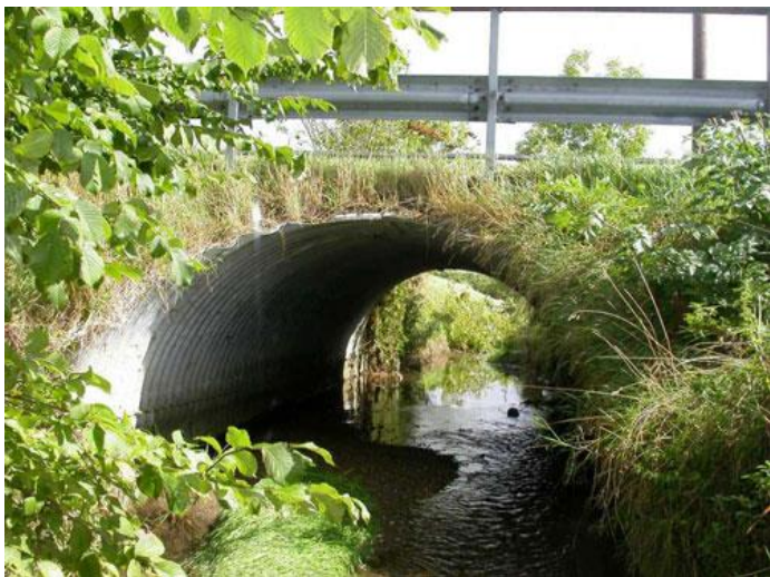
Figur 5.11. Exempel på rörbro.
