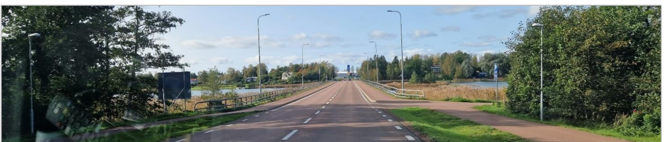
Figur 29. LV 1 Hammarlandsvägen. Utsikt mot Svibybron vid stadsgränsen.
