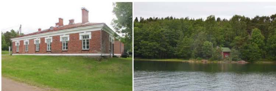
Figur 5.3 Telegrafbyggnaden på Prästöuppförd ca 1912-13 (till vänster). Till höger syns stranden söder om färjästet på Prästö. Nära stranden finns äldre markstrukturer som återfinns på kartan från 1775.
