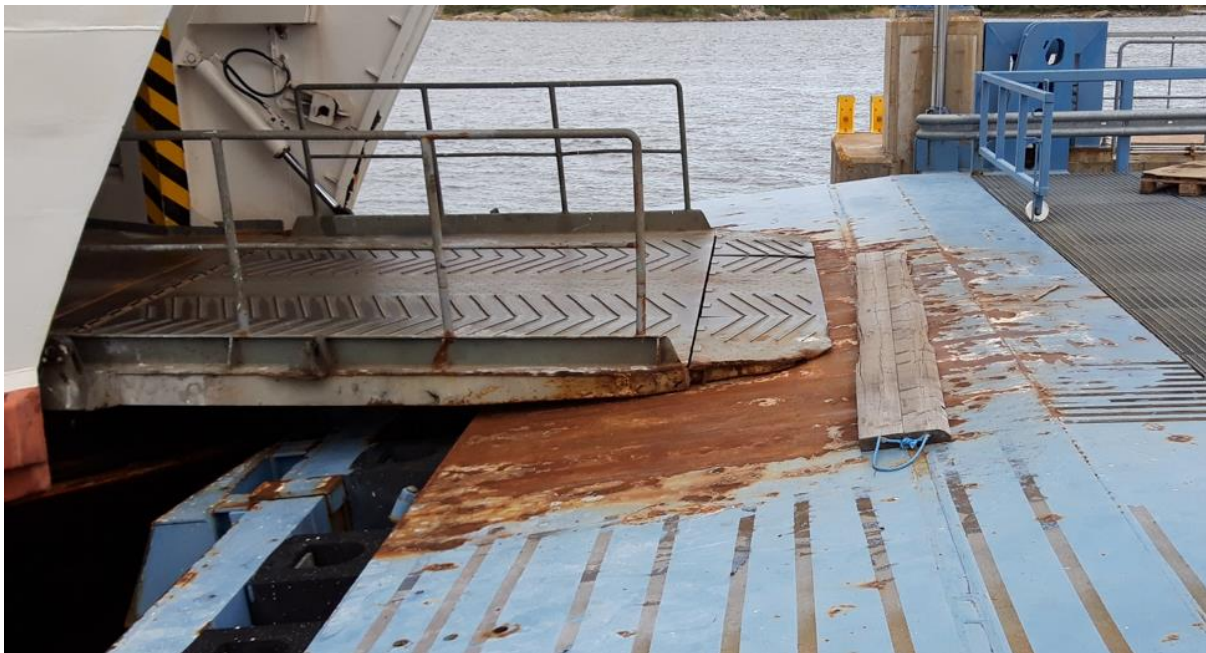
Figur 14. Kökar färjfäste med justerbar fast landklaff som kan ändras till samverkande modell
