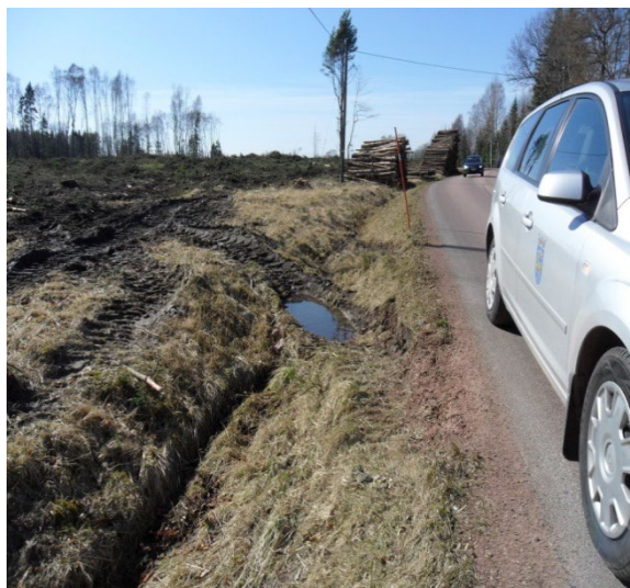
Skador på diken och vägtrummor där den som orsakat skadorna är återställnings-/ersättningskyldig. I bakgrunden ses två vältor som utsätter trafikanter för fara då de är fel-placerade och den ena lutar in mot vägen och utgör rasrisk.
